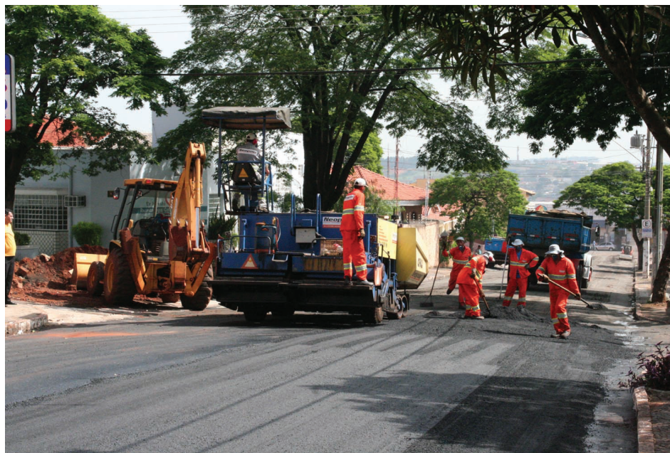
Obras de recapeamento estão em operação no Jardim São Judas Tadeu, região da Área Cura
