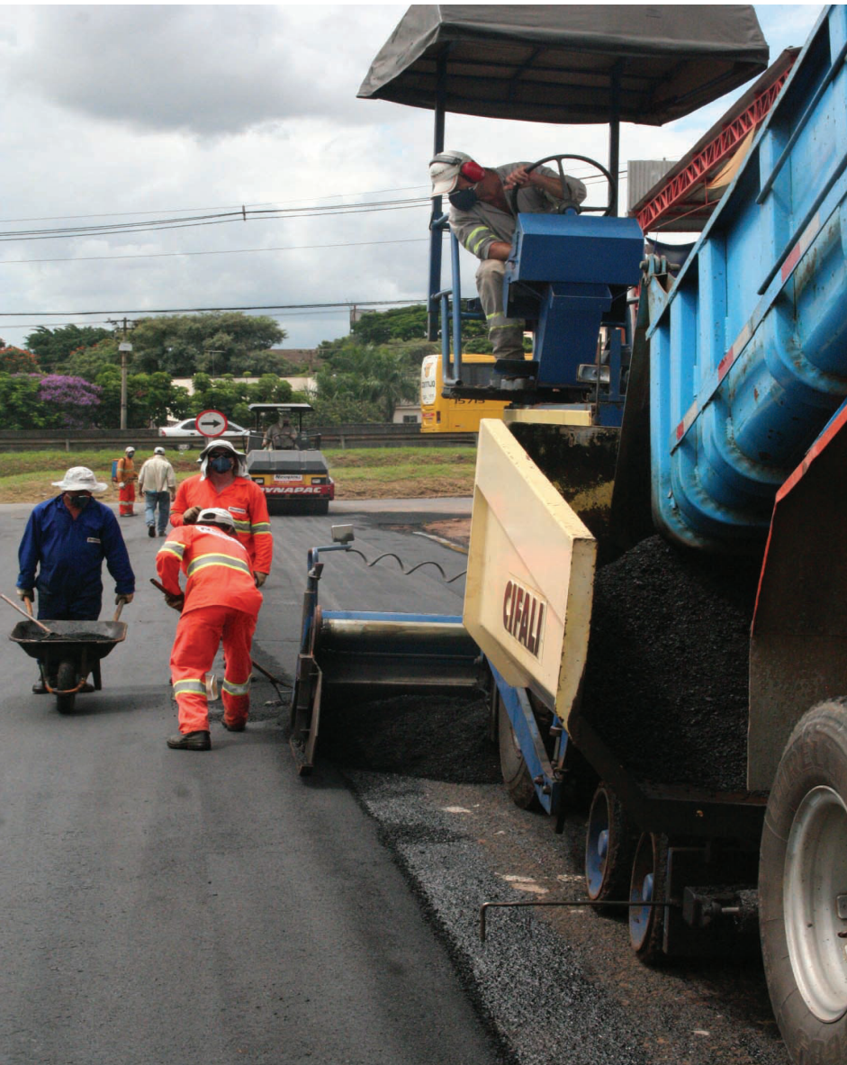
Obra de recapeamento vem sendo realizada no Jardim São Judas Tadeu
