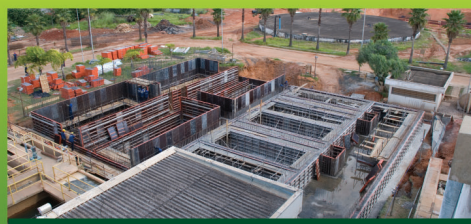
OBRAS DO PAC + ÁGUA PARA TODA A CIDADE
