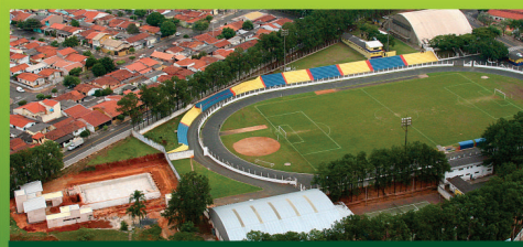
REFORMA DO CENTRO ESPORTIVO
